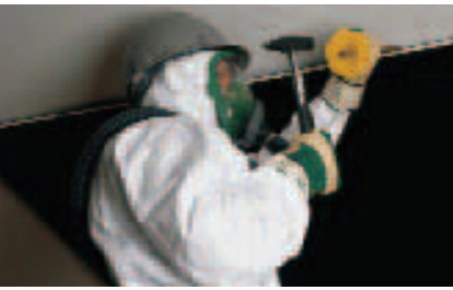
Abriss- und Montagearbeiten
